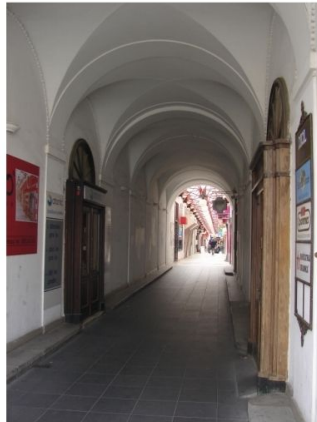
pohled průchodem směrem k pasáži
